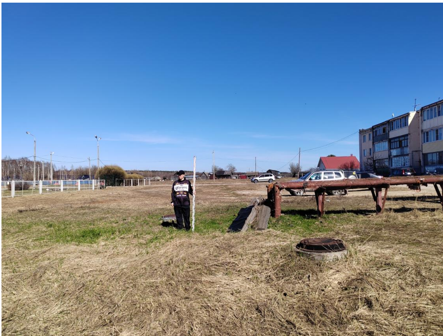
Илл. 9. Нижегородская обл., Лысковский м.о., строительство блочно-модульной котельной (на природном газе) в с. Валки, пер. Школьный - 2026 г. Вид на центральную часть участка. Точка фотофиксации 1. Фото с ЗЮЗ.
